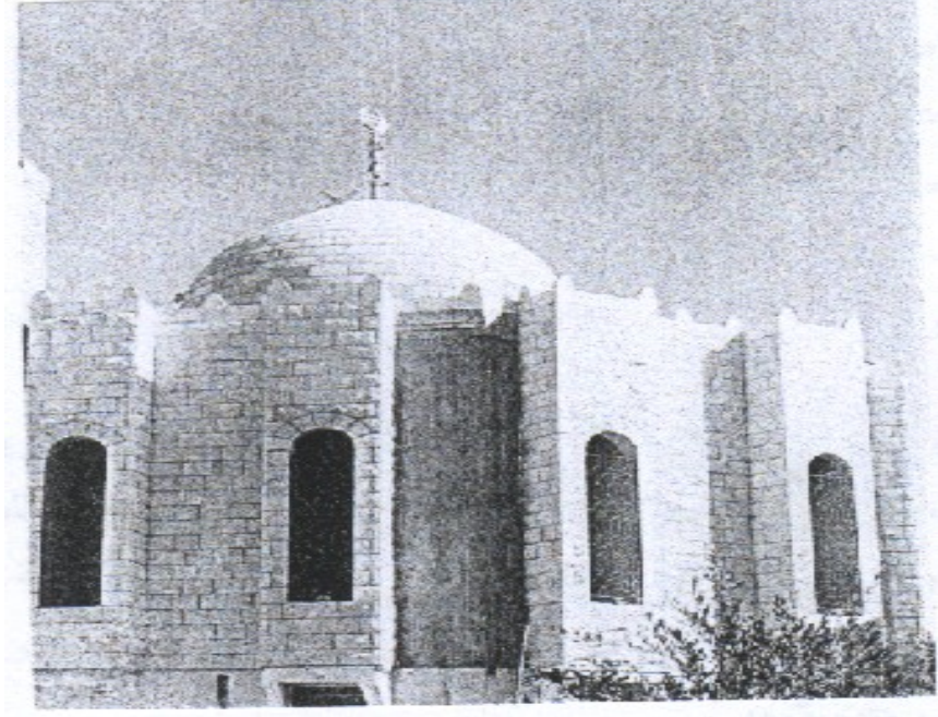
شكل (١٤): صورة المسجد بعد انتهاء بناء القبة
