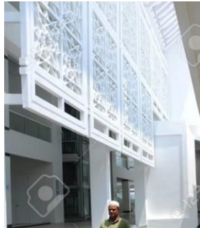
استخدام كوليسترا مفرغة بالأشكال الهندسية أمام فتحات الواجهات لتقليل الإبهار داخل مسجد Cyberjay في ماليزيا
