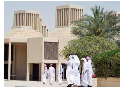
استخدام ملاقف الهواء في جامعة قطر
