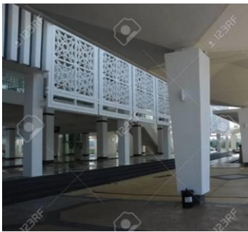
استخدام كوليسترا مفرغة بالأشكال الهندسية أمام فتحات الواجهات لتقليل الإبهار داخل مسجد Cyberjay في ماليزيا
