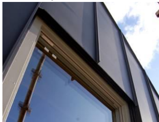
الزجاج الثنائي المطلي بمواد تعزل الفراغات حراريا
