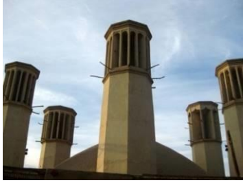
ملاقف هواء لخزان مياه لترطيب هواء المدينة -يزد- إيران
