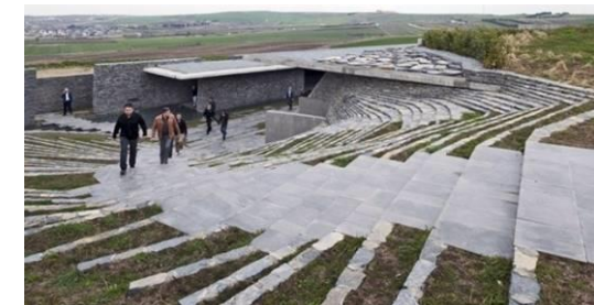
شكل (20) يوضح تصميم مسجد Sancaklar تحت سطح الأرض لعزل المسجد عن ضوضاء الطريق.
