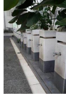
شكل (27) يوضح استخدام مياه الوضوء في ري النباتات وقطاع رأسي في مسجد Green Mosque في أنقرة بتركيا يوضح إعادة استخدام مياه الرمادية في الري
