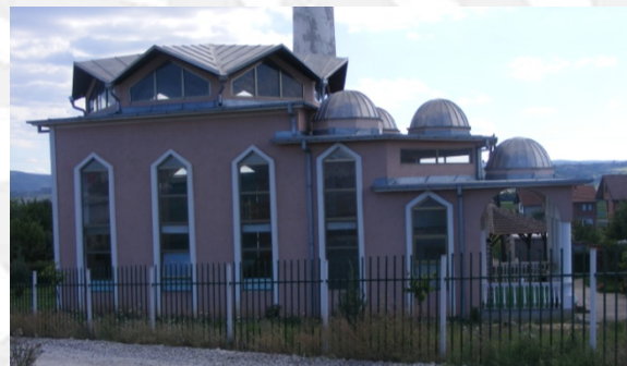
Fig. 5.20 "Hajratit" Mosque, Podranqë - Vushtrri
