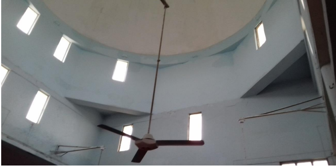
الصورة رقم (٣) تحويل الشكل المربع إلى مئمن وإقامة القببة
