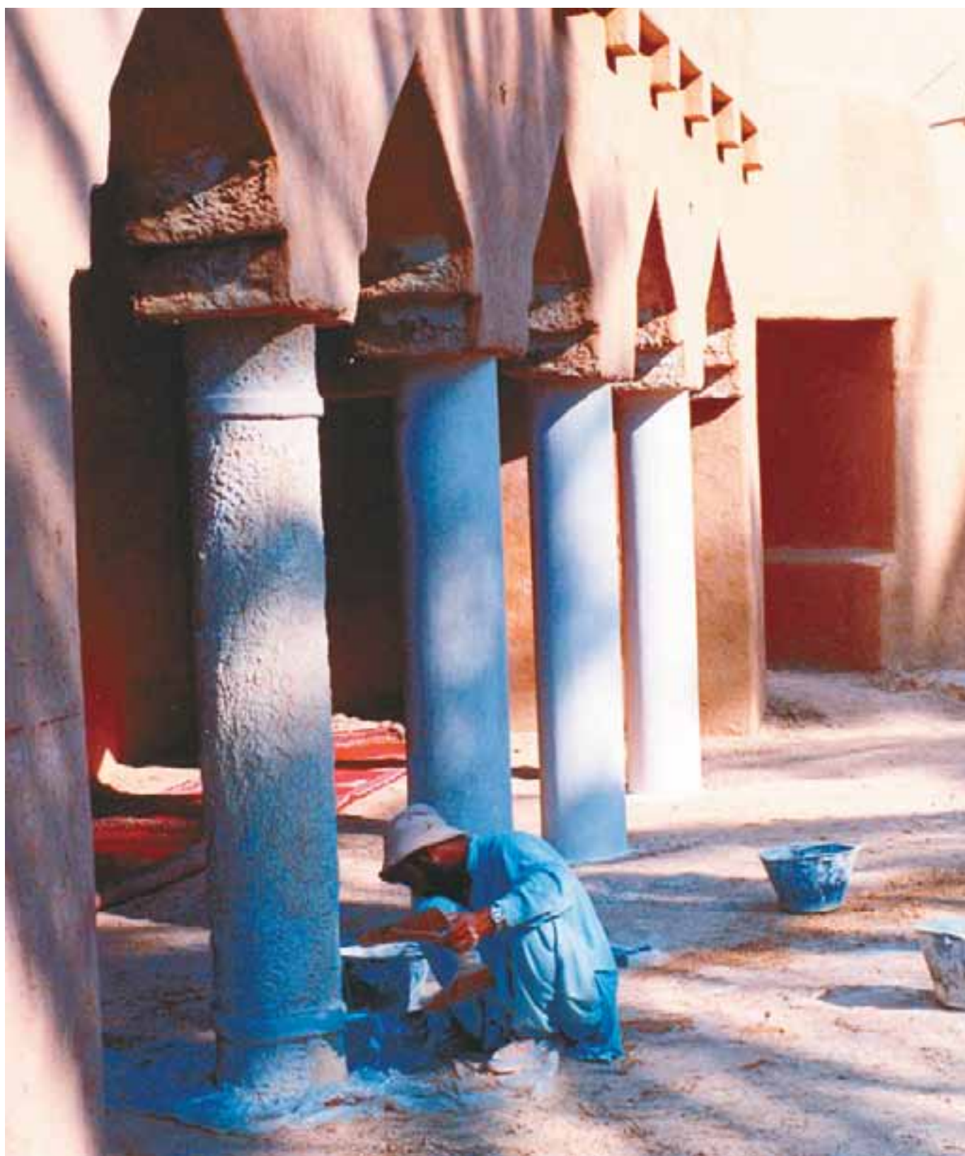
▲ أعمال الترميم في مسجد العذيبات، ١٩٩٠م
