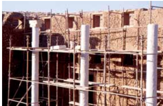
تم ترميم أعمدة الديوانية في البداية، قبل أن يعاد بناؤها بالكامل
