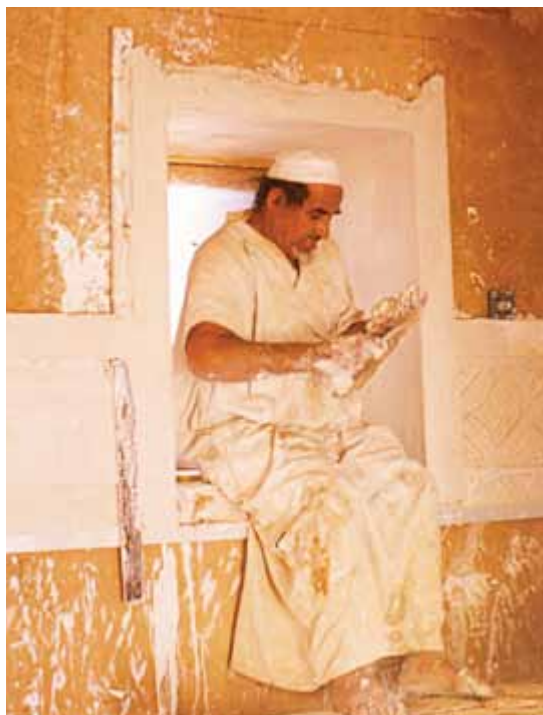
معلم البناء عبد الله بن حامد يعمل في الجص الخاص داخلياً أثناء عملية إعادة البناء.
