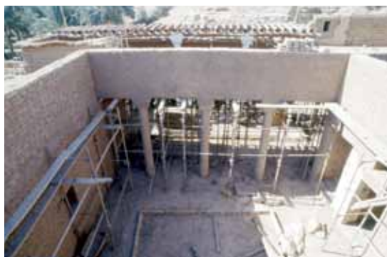
الإعداد لإعادة البناء: السقالات تدعم سقف الرواق وسقف الديوانية، بينما أُزيل الحائط الشمالي القديم للديوانية، لإعادة بنائه بالكامل بمواد جديدة.
