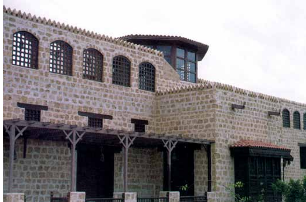
فيلا نصيف في جدة، تصميم حسن فتحي، وبنيت باستخدام الكتل المرجانية التقليدية لساحل البحر الأحمر.
