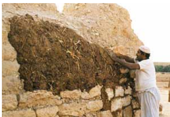
معلم البناء عبد الله بن حامد يعمل في الجدران أثناء عملية إعادة البناء.
