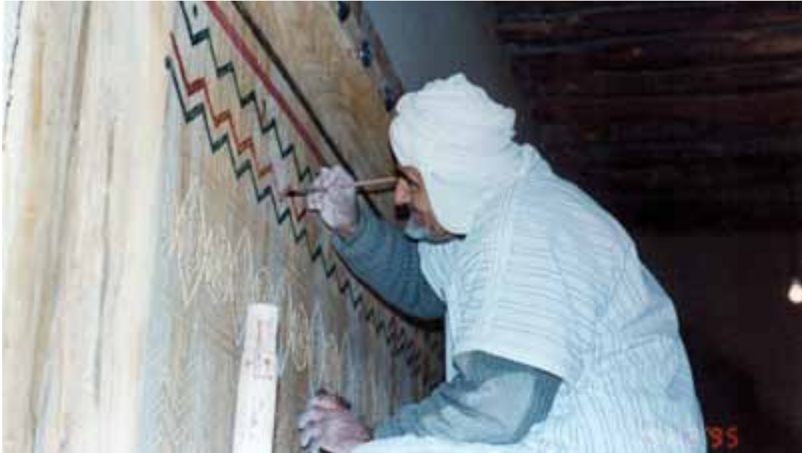
معلم البناء عبد الله بن حامد يعمل في الزخارف الداخلية أثناء إعادة البناء.
