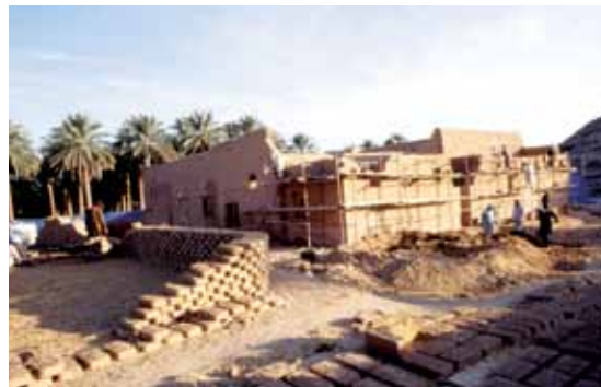
إلى اليسار: الجانب الغربي أثناء البناء، يلتحق بالجدران القائمة للبيت القديمة.
