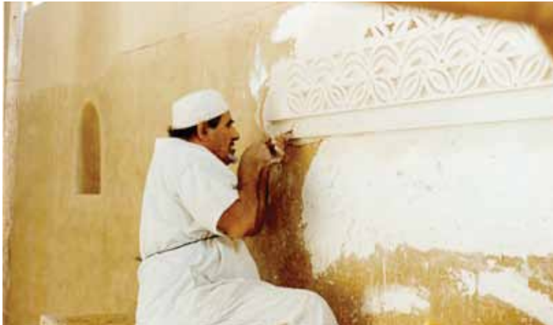
معلم البناء عبد الله بن حامد يعمل في نحت التصميم الداخلي أثناء إعادة البناء.
