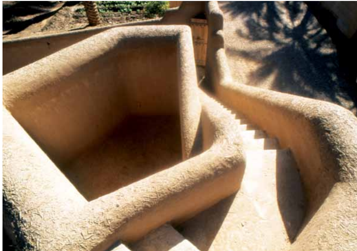
يساعد التبن كأحد مكونات خليط الطين في منع التآكل بتأثير المطر، كما يمكن أن نرى هنا على قمة الحواجز العلوية لمسجد العدييات
