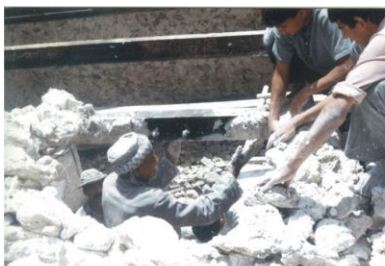
شكل رقم (18): الطريقة التقليدية في بناء العقادة المرمر الموصلية والمستخدم في الحالة الدراسة (المصدر: الباحث).
