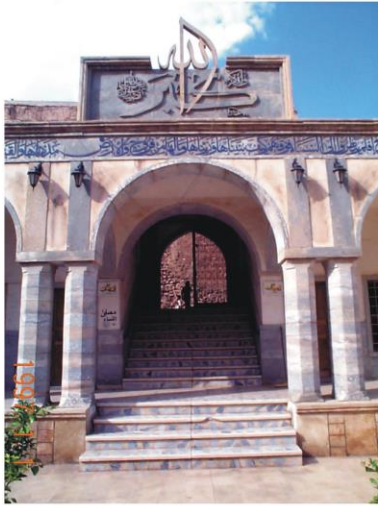
شكل رقم (6): رواق المدرسة الدينية المرتبط بمدخل المسجد (المصدر: الباحث).
