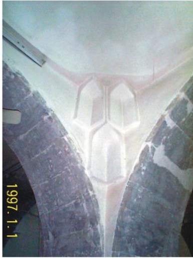
شكل رقم (12): المقرنصات في بوائك المصلى (المصدر: الباحث).
