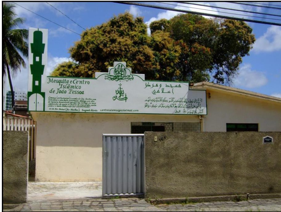
Figura 13 – Fachada da Mesquita e Centro Islâmico em João Pessoa - Paraíba – Brasil
