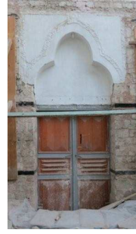
Fig. 12: Blind Trefoil Arch Above the Door
