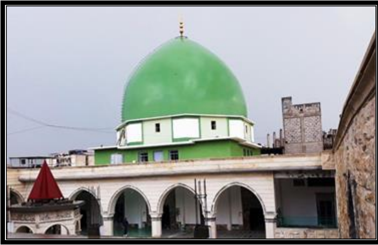
د/ قبة المصلى ورواقه بصورة نهائية بعد إتمام اعمال البناء
