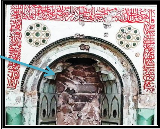
ب/ أضرار مقرنصات المحراب
